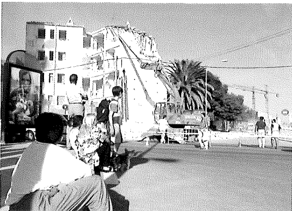
Demolición del antiguo Barrio Mil Viviendas, Alicante (ISABEL RAMÓN, Archivo INFORMACIÓN)
