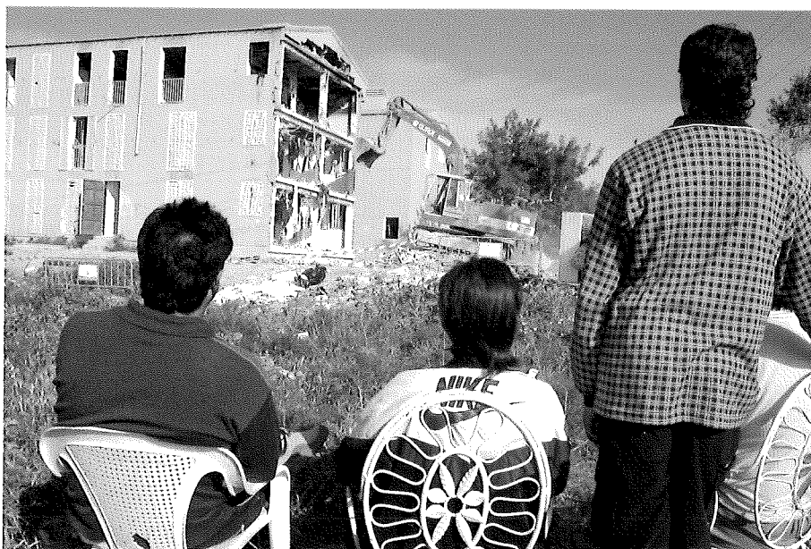
Derribo de edificios en Parque Ansaldo (PILAR CORTÉS, Archivo INFORMACIÓN).
